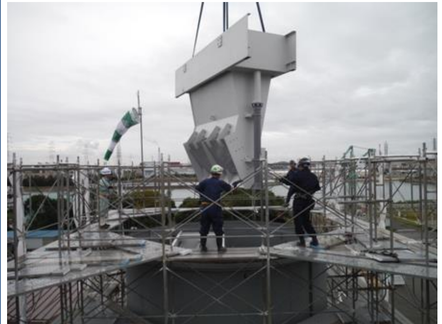
セトラ設置工事の様子
