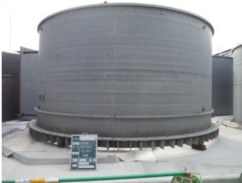
反応槽設置工事の様子
