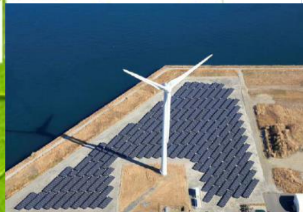
風力発電 (2,300kW×2基) 太陽光発電 (1,600kW) 278Wパネル5,588枚設置
