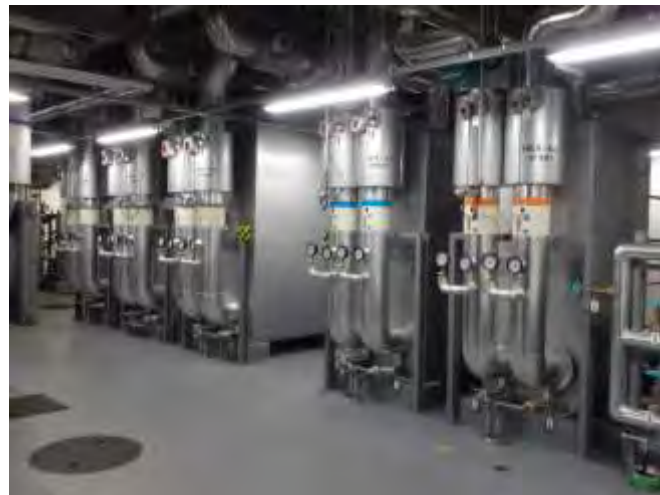
プレート熱交換器（計5台）
