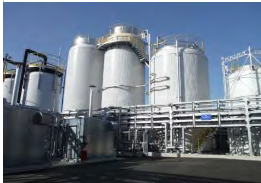
嫌気処理設備設置完了の様子
