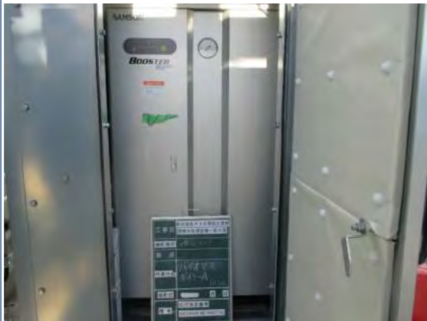
ボイラー設置完了の様子
