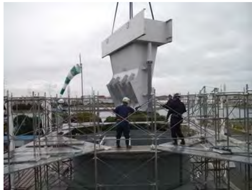
セトラ設置工事の様子
