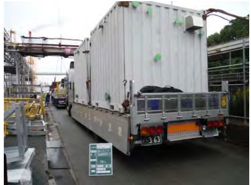
生物脱硫機器ユニット搬入の様子
