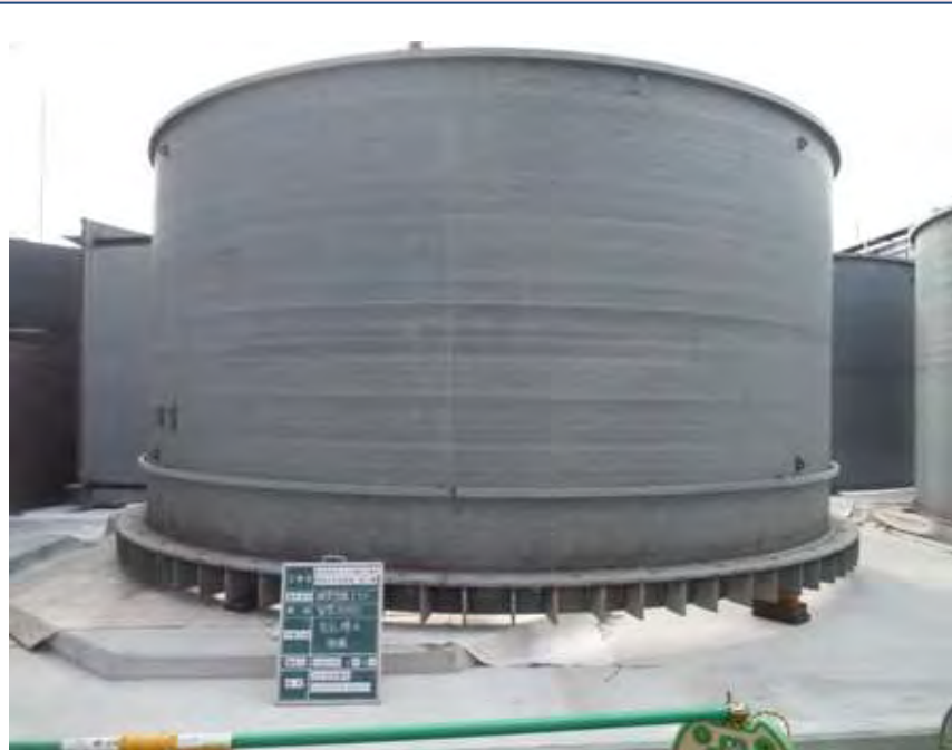
反応槽設置工事の様子
