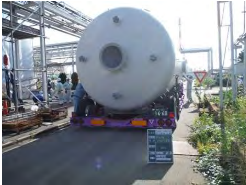
生物脱硫塔搬入の様子
