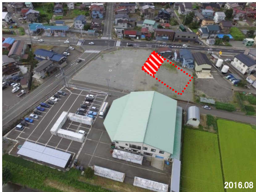
施工前整地した予定地
