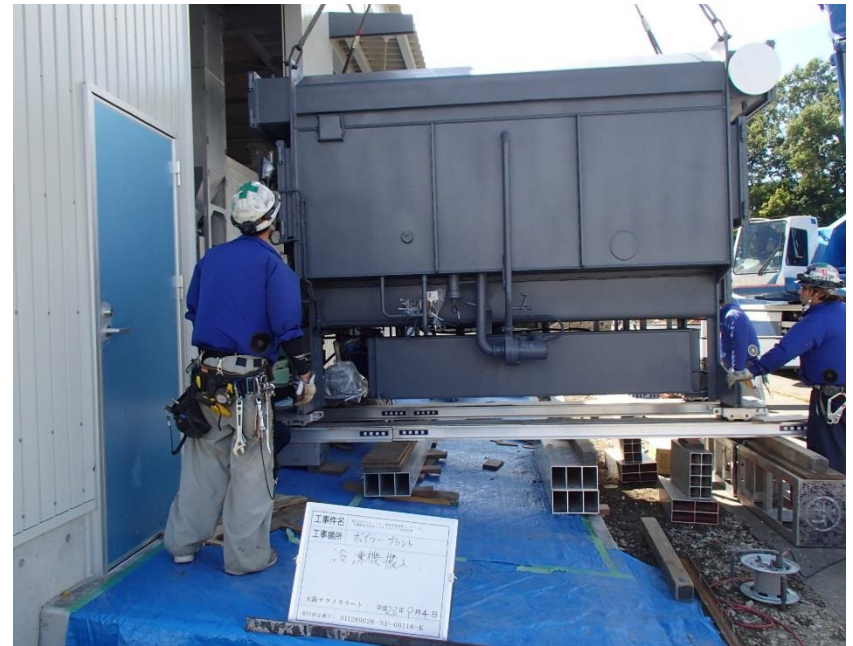
吸収式冷凍機搬入の様子
