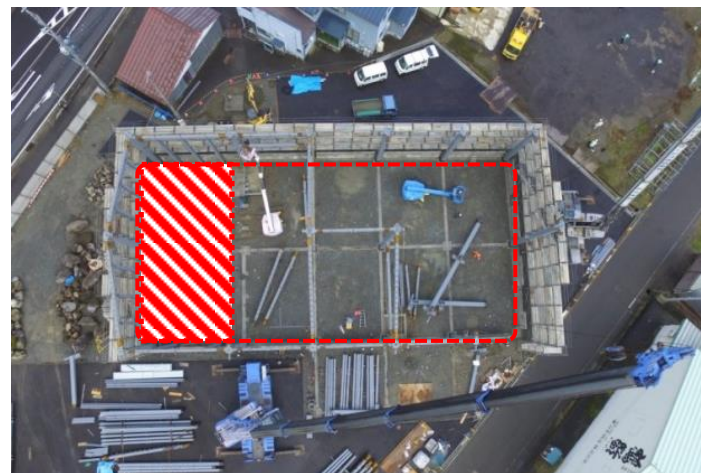
生コン基礎、鉄骨建て
