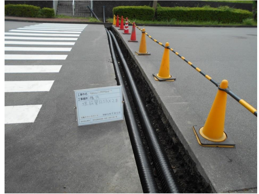
熱導管の埋設の様子
