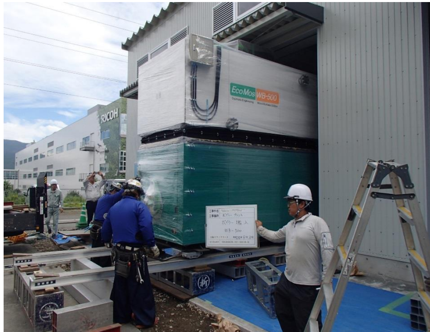
木質バイオマスボイラー搬入の様子
