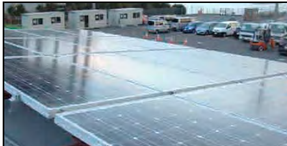
太陽光発電・集熱ハイブリッドパネル ／日比谷総合設備株式会社
