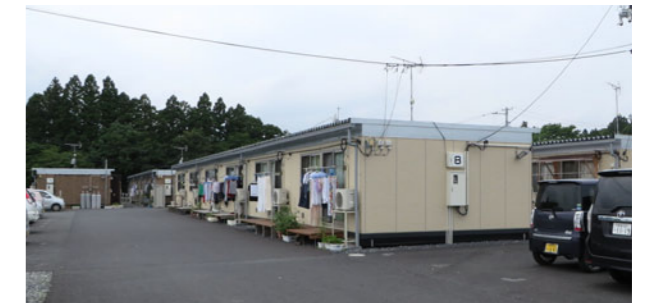
図 1-8 既存の仮設住宅では、温熱環境、結露、防犯性能などの課題が挙げられる
