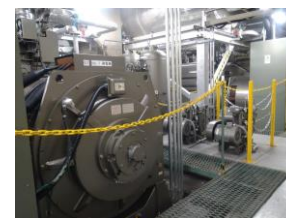
ディーゼルコジエネ:2台 発電出力：580kW
