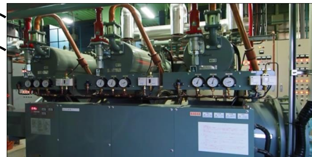
スクリー式冷凍機
