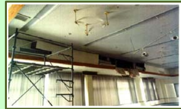
平成28年4月の熊本地震(最大震度7)による被害箇所(リハビリ棟)
