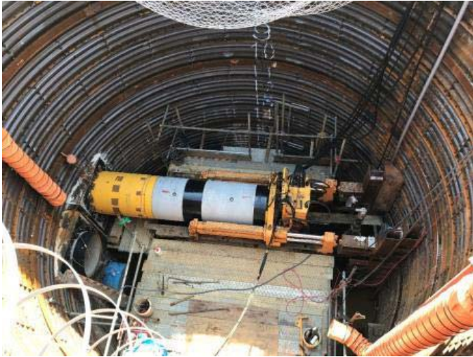
市道横断部 推進工事
