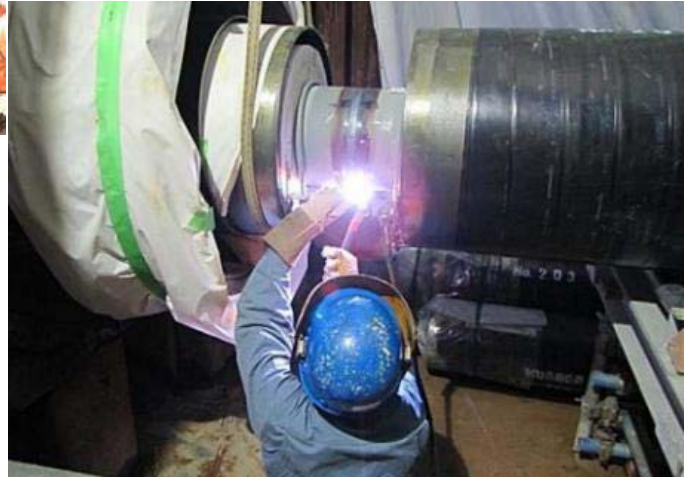
蒸気二重管(埋設部) 溶接作業
