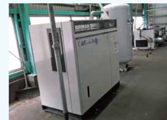
2. インバータ制御コンプレッサー 吐出量 6.9m³/min. 吐出圧 0.8MPa
