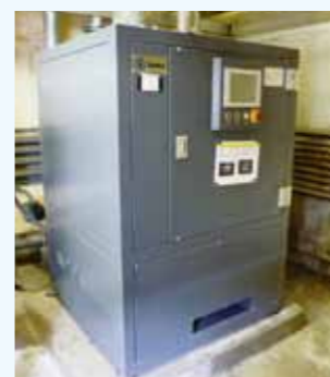
4. 高効率ブロワ 風量47.8m 3 /min.以上 吐出圧力53.9kPa以上
