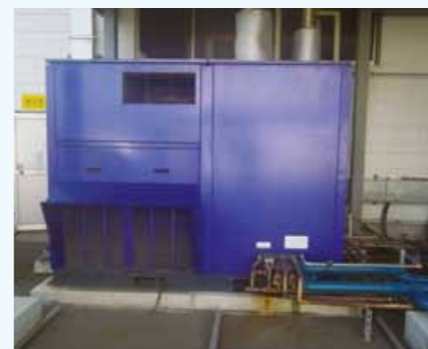
1. 圧力制御型小型蒸気発電機 出力 100kW
