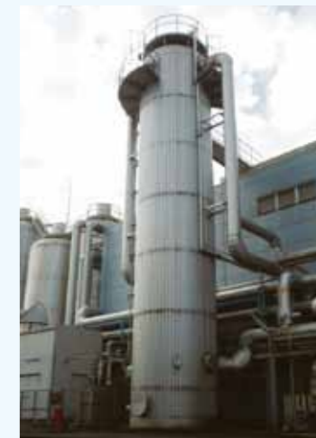
3. ブライントank 冷却液(冷媒)をためるタンク
