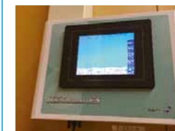
4. EMS装置 冷凍機と冷凍冷蔵ショーケース間の統合制御。低圧シフト制御、防露ヒーター制御、デマンド制御を自動コントロール。
