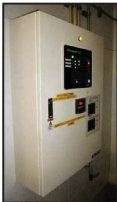
・台数制御装置設置
